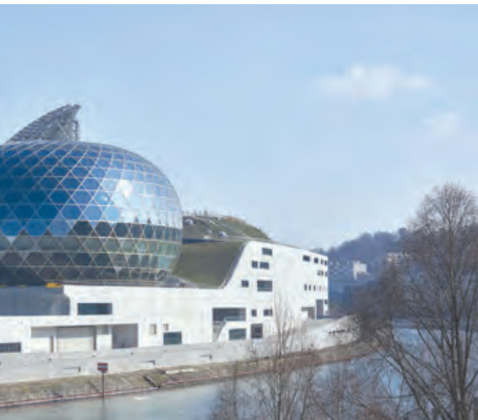
view of new concert hall of Boulogne-Billancourt built on an island in the Seine River ბულონ-ბილიანკურის ახალი საკონცერტო დარბაზი კუნძულზე მდ.სენაში
